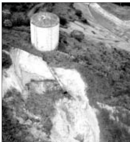
Deslizamiento en tanque de almacenamiento J. Grases, 1998
