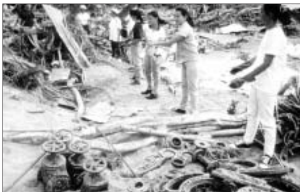
Afectación a bodegas de la empresa de agua Tegucigalpa, Honduras, a raíz del huracán Mitch.
