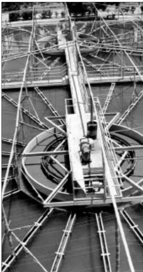
Medida de emergencia instalación de estructura para evitar caída de cenizas, protegiendo planta de tratamiento. Erupción Volcán Pichincha, Ecuador, 1999
