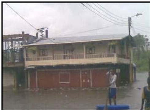
Foto: Crepad. Inundación en Medio Baudó- Choco
