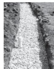
De ese modo el efluente se purifica por la acción de las bacterias aerobias saprofitas que existen en el suelo y se filtra por el terreno.
