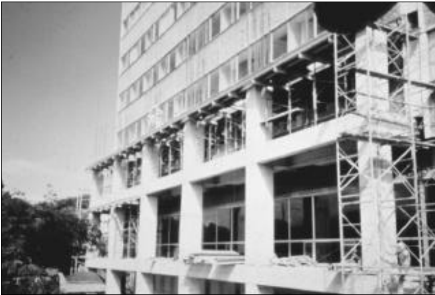
Fotografía 14. Refuerzo del Hospital México
