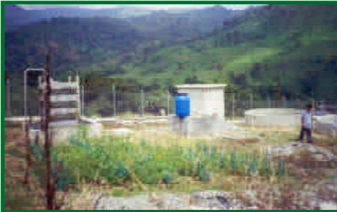
Componentes de la planta de tratamiento de agua potable, aereador, caseta de cloro y tanques de reserva en la planta de tratamiento de la población de Sardinas.
