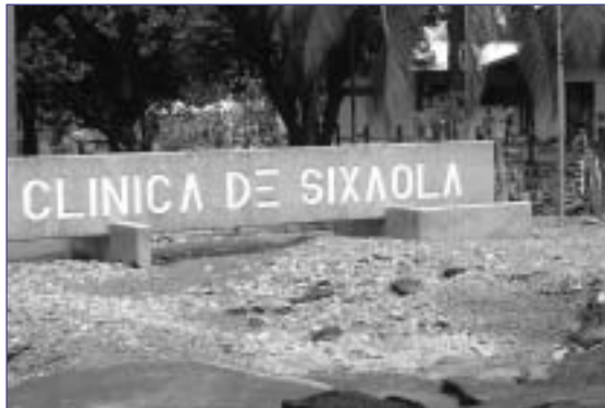
Foto 16. Clínica Sixaola fuertemente afectada por inundaciones. Provincia de Limón. Costa Rica, 2005.
