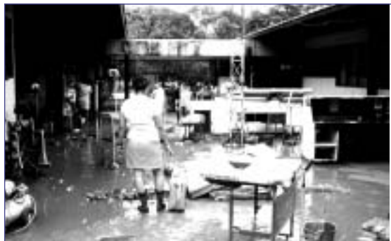
Foto 17. Destrucción de equipamiento y mobiliario en la clínica Sixaola ocasionada por inundaciones. Provincia de Limón. Costa Rica, 2005.
