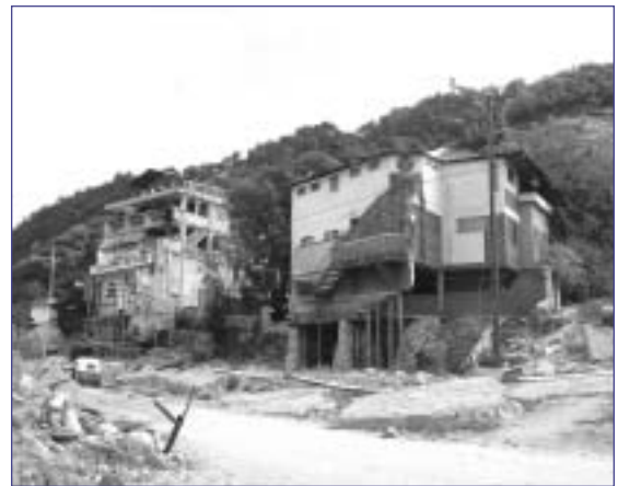
Foto 22. Destrucción de elementos estructurales como consecuencia de inundaciones. Panajachel, departamento Sololá, Guatemala, 2005.
